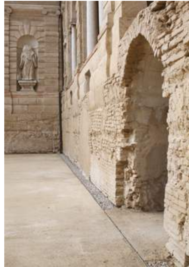
2. Dettaglio della parte basamentale del chiostro grande. Fotografia di Kai-Uwe Schulte Bunert (2019).
