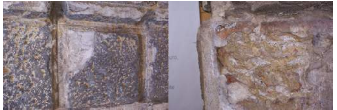
7. Prospetto delle Pescherie di Levante: bugna grigia colorata in pasta su arriccio in calce e sabbia (a sinistra); bugna mossa gialla con finitura colorata in pasta su arriccio in calce e sabbia (a destra).
