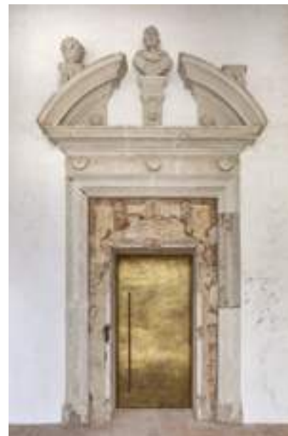
6. La porta in ottone della sala centrale dell'ala nord con la cornice in stucco e lacerti murari affrescati. Fotografia di Alessandra Chemollo (2019).
