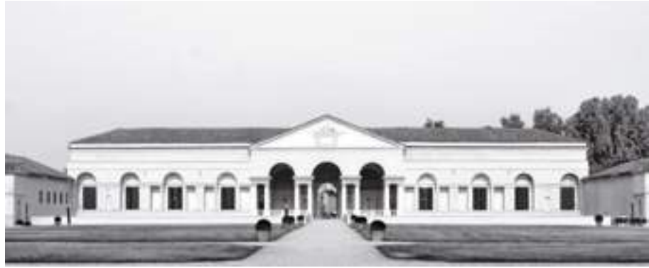
3. Mantova, Palazzo Te, prospetto orientale verso le peschiere. Fotografia di Ludovica Cappelletti, 2018.
