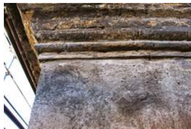
3. Particolare di una finestra del piano nobile su piazza di Sant'Eustachio. La malta a base di pozzolana grigia, di accompagnamento tra la cornice della finestra e il fondo, appare volutamente "a rustico", in analogia con la lavorazione del travertino (novembre 2016).
